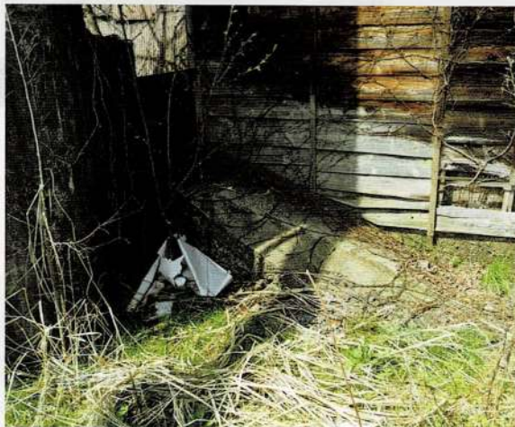
地下設備へ通じる穴。戸出町1丁目には今も蒸気機関の痕跡が残っている。
