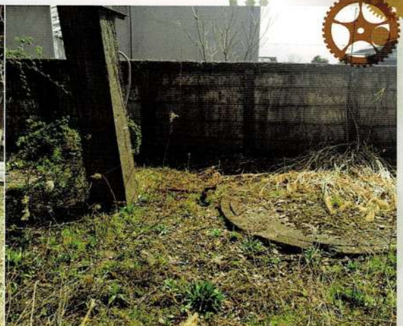
地下設備と蒸気機関室とを繋ぐコンクリート
